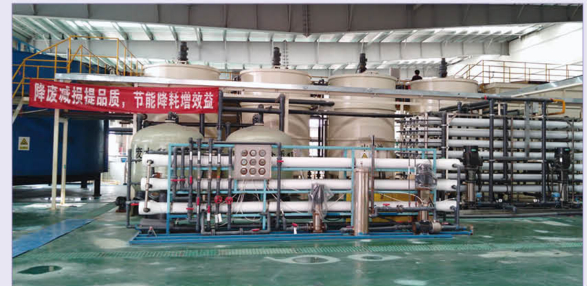
有研合肥污水处理系统
